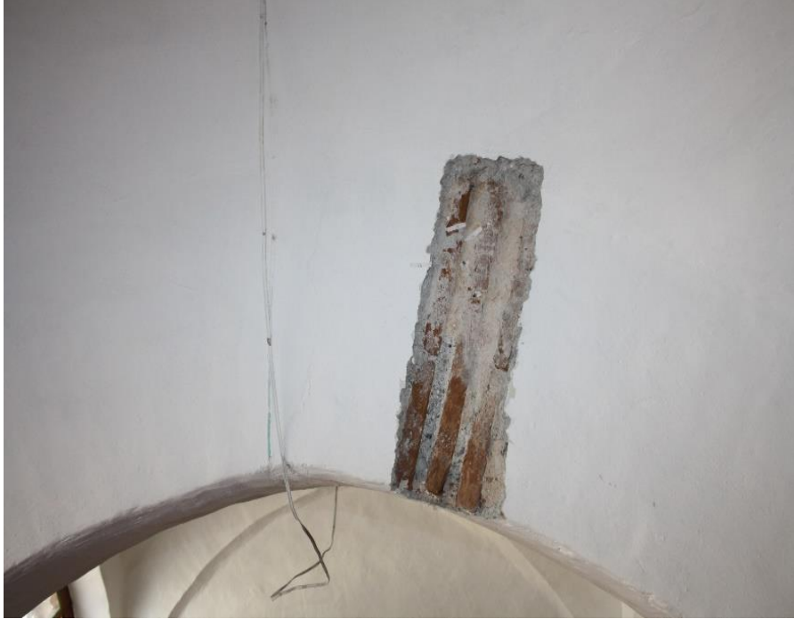
Fot. 9 Alaca Mescid Cami tuğla kemer detayı
