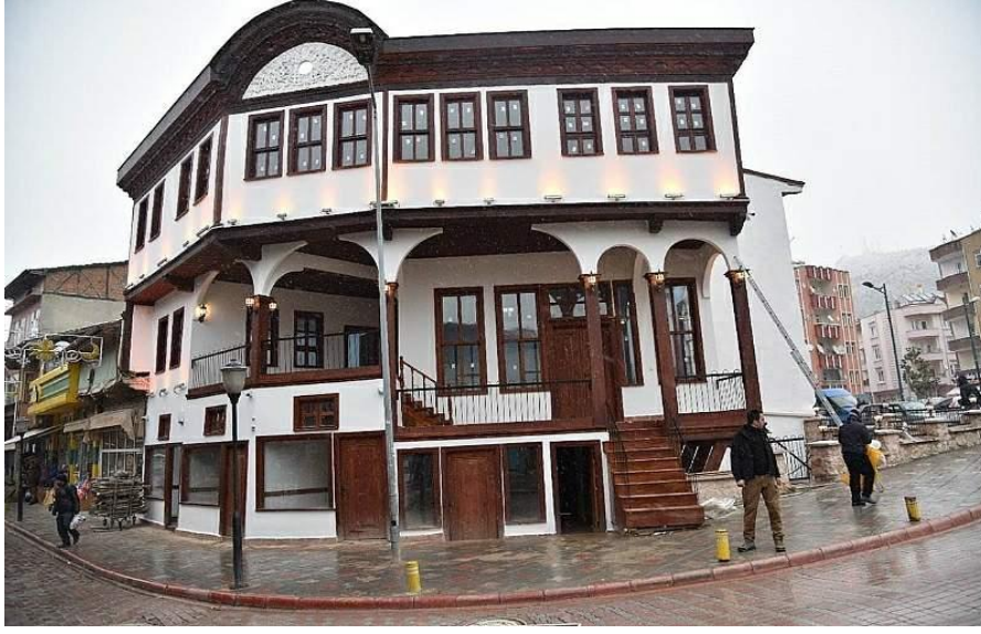
Şekil 12: Restorasyon uygulama sonrası görünüm
