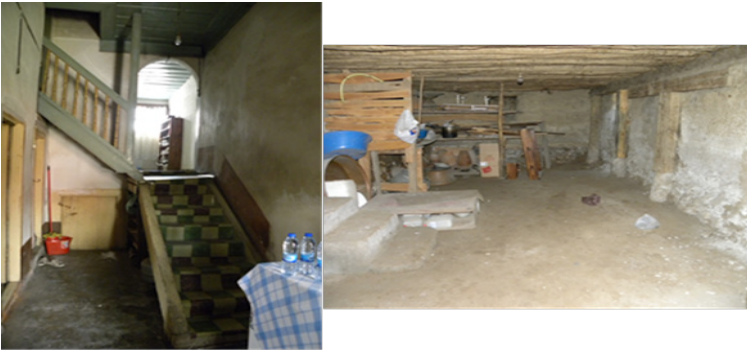
Resim 9. Zemin kattan yarım kat yükseltilmiş kısmın alt katındaki bodrum kat.
