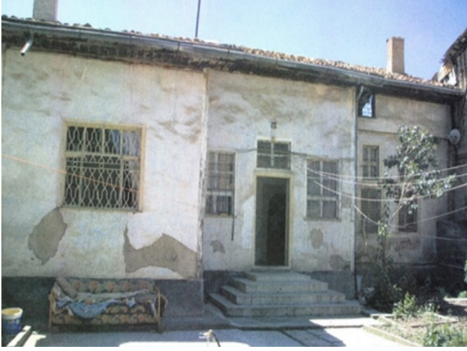
Resim 12. Konutun restorasyon çalışması öncesi cephesi (Envanter). 10
