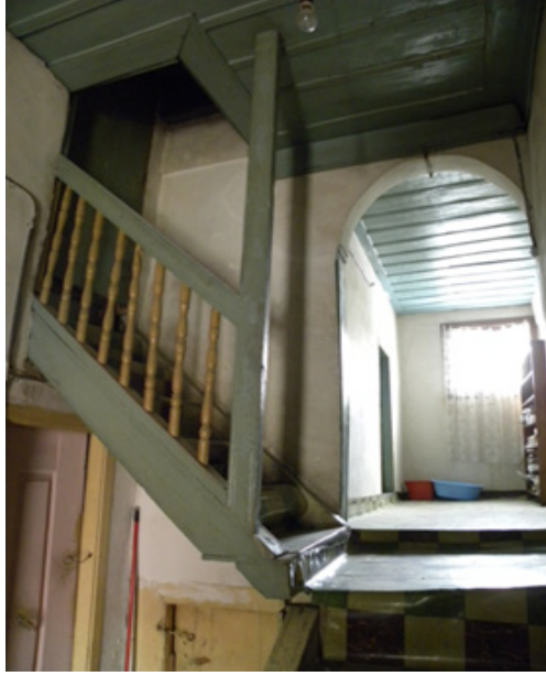
Resim 3. Zeminden çatıya kadar çıkan merdiven.
