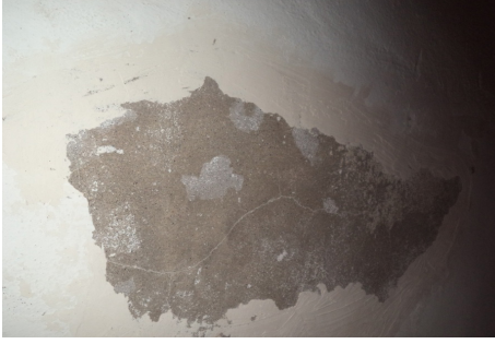
Foto 37: Hamzabey Camisi, iç duvarda badana altındaki sıva
