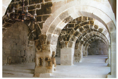
Foto 20: Mahperi Hatun kervansarayı, avlu revak ayak ve kemerlerindeki taşların arasındaki fark.(Sunay, a.g.e., s.268)
