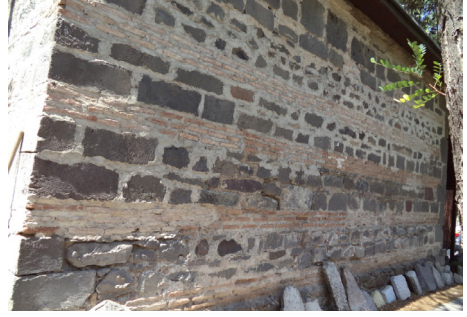
Foto 41: Niksar Melikgazi Türbesi cephe duvarlarında almaşık sistem uygulaması
