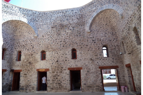
Foto 8: Niksar Yağibasın Medresesi, son onarımdan sonra iç duvarlar
