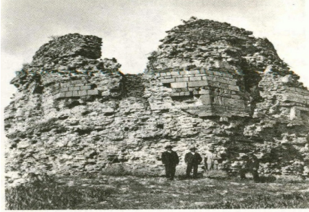
Foto 7: Niksar Yağibasın Medresesi, moloz taşların arasında yer alan tuğla hatıllı kesme taşlar.(Kuran a.g.e s..)
