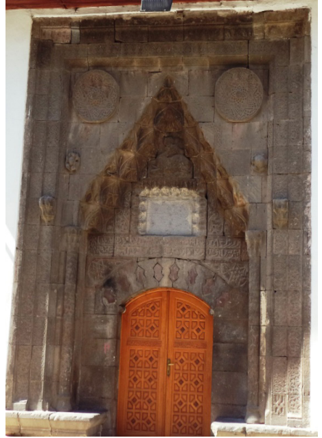
Foto 26: Niksar Çöreğibüyük Tekkesinden günümüze gelen taç kapısı
