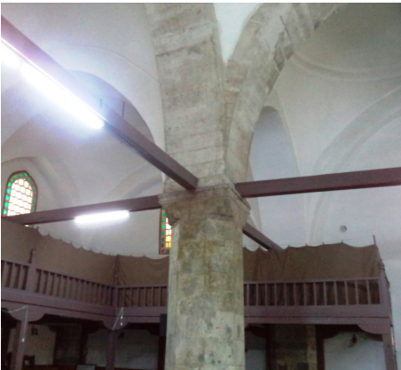
Foto 35: Takyeciler Camisi, Kubbeleri taşıyan kesme taş kemer ve ayak
