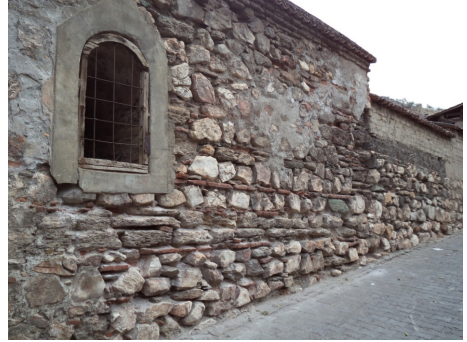
Foto 43: Paşa Hamamı, duvar örgüsü
