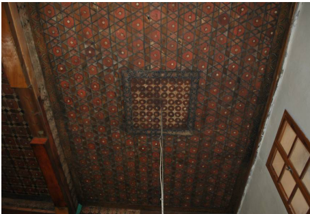
Fotoğraf 9: Güneydoğudaki tavan bölümü
