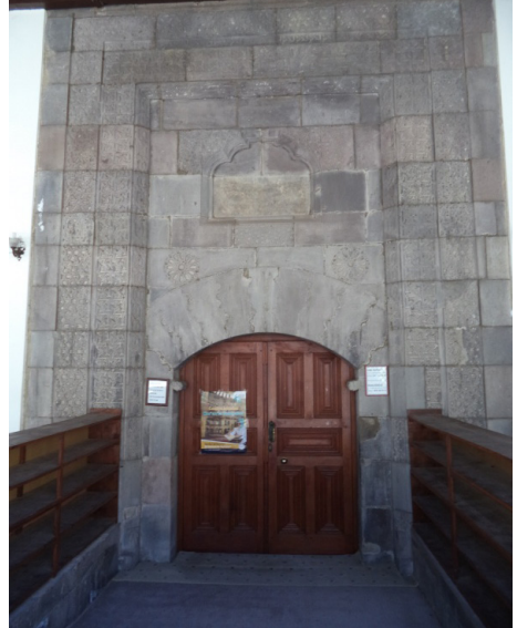
Foto 4: Niksar Ulu Cami, Taç Kapı
