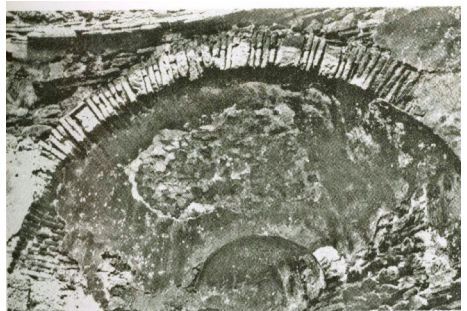
Foto 10: Tokat Yağibasın Medresesi, eski bir fotoğrafında tromp(Kuran a.g.e., s..)
