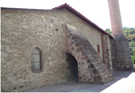
Foto 3: Niksar Ulu Cami, yan cephe duvarı, payanda ve minare kaidesi
