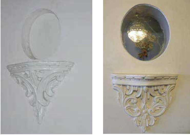
Şekil 4. Lambalığın yaslandığı duvarın üzerinde bulunan oval niş ve pencere
