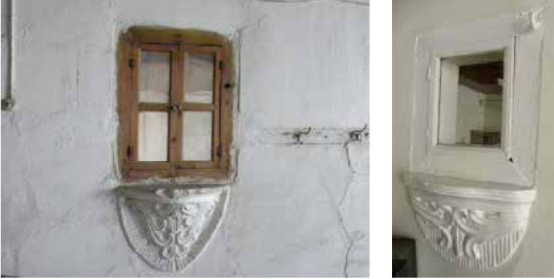
Şekil 5. Lambalığın yaslandığı duvar üzerinde bulunan pencere
