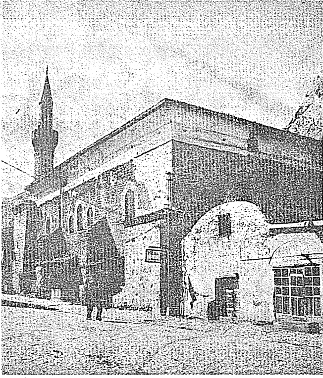
Resim 8 — Takıyeciler Camisi, Restorasyon Öncesi Genel Görünüş.
