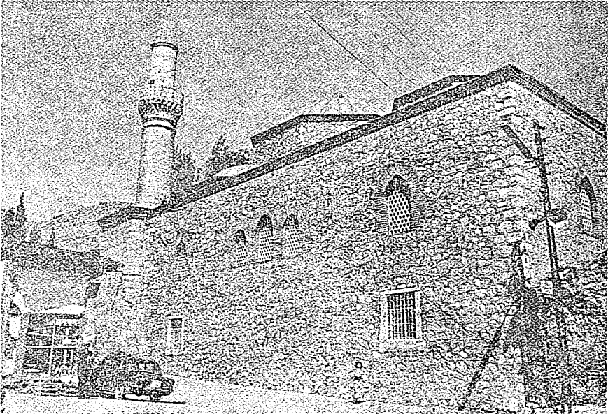
Resim 9 — Takıyeciler Camisi, Güney Cephe.
