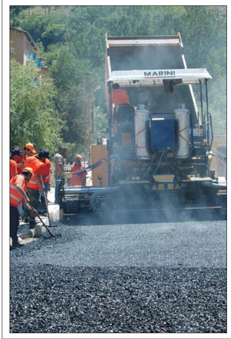
Duble yol yapım çalışmaları
