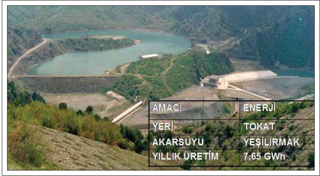
Ataköy Barajı ve Hidroelektrik Santrali
