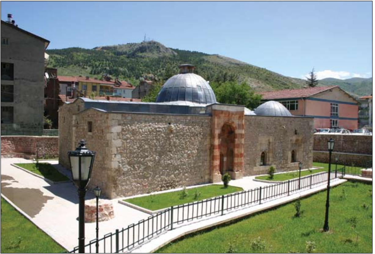
Halef Sultan Zaviyesi
